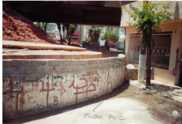
Figura 87 – Foto da rede de esgoto mal dimensionada transbordando
