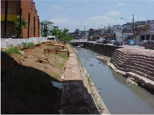
Figura 110 – Foto do “solapamento” das margens do córrego
