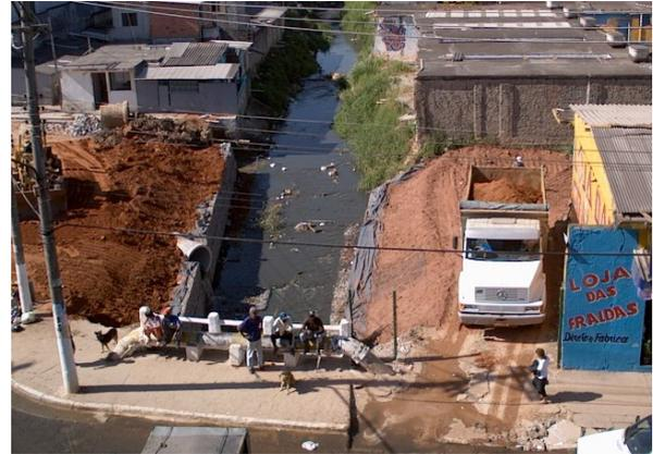
Figura 130- Foto dos gabiões instalados na margem do córrego
