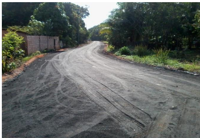
Figura 44 Asfaltamento da estrada que dá acesso à Vila de Paricatuba
