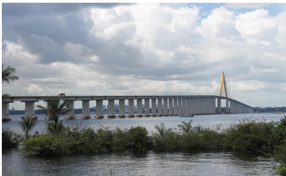
Figura 12 - A ponte estaiada sobre o rio Negro
