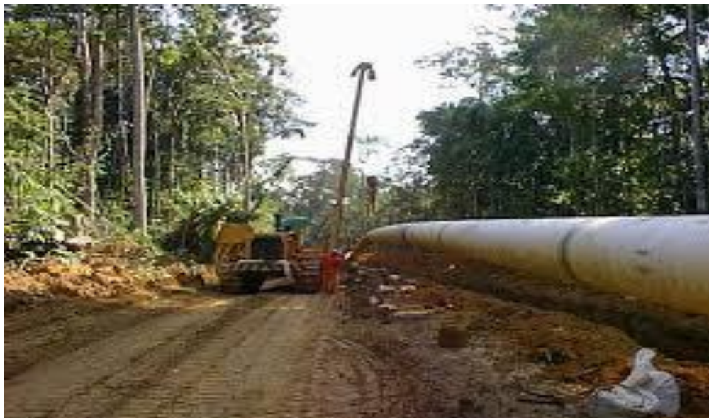
Figura 9 - Construção do Gasoduto Coari-Manaus
