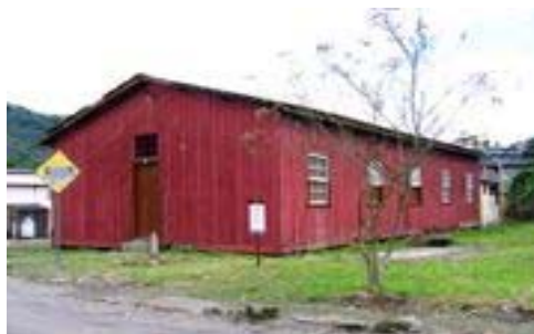
Figura 9: Casa de solteiro em madeira.
