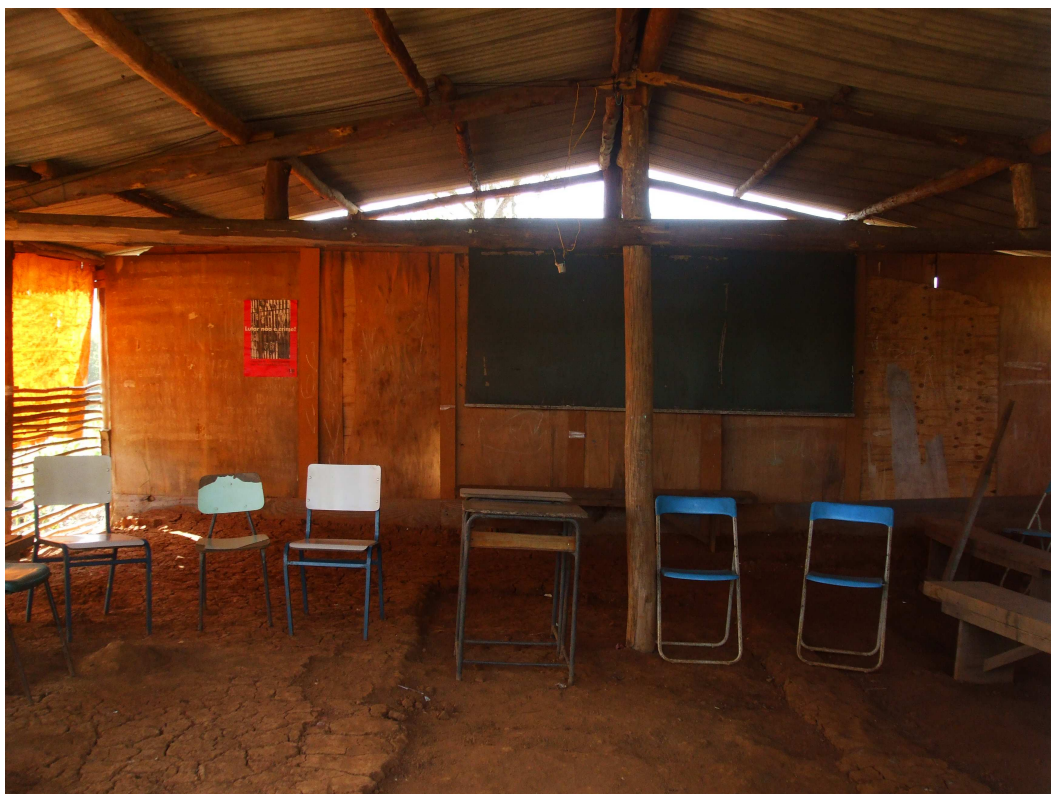
Foto 2: Falta de infraestrutura da sala de aula. Andréia Jofre, maio de 2010
