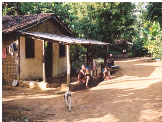
Foto 3 – Casa de estrutura frágil na comunidade, núcleo São João, 2004
