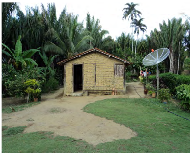
Foto 2 – Casa de estrutura frágil na comunidade, núcleo São João, 2012
