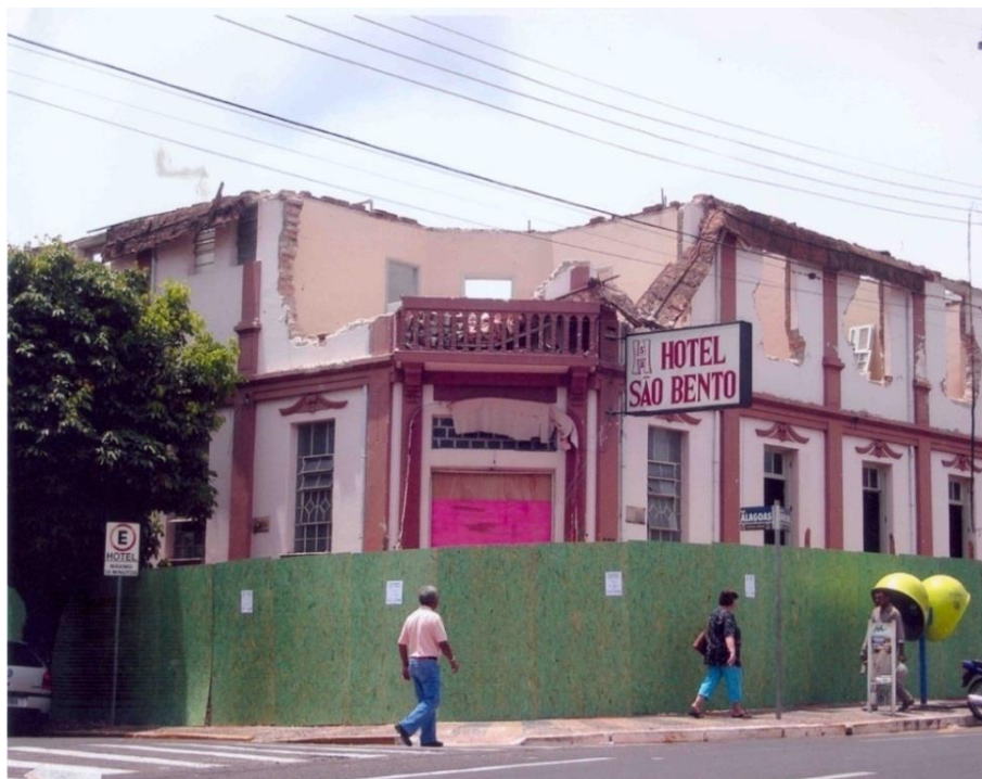
Figura 30: Fotografia retratando a demolição do Hotel São Bento, um dos principais imóveis da cidade de Marília, valorizado pelos grupos sociais ligados a setores culturais (membros da Comissão, arquitetos, professores, entre outros) como seu patrimônio para a construção de uma agência bancária. Um dos principais usos da imagem pela Comissão dos Registros históricos supõe-se, é apresentar os efeitos do progresso desenfreado, que destrói e mutila edificações consideradas como marcos simbólicos da urbe. Autora: Wilza Aurora Matos Teixeira.
