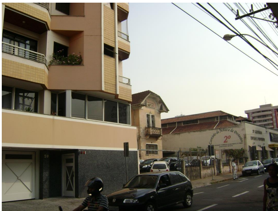
Figura 05: Fotografia que apresenta a área envoltória da edificação tombada. É possível perceber o quanto a construção do edifício ao lado do imóvel protegido pelo Estado, autorizado pela Prefeitura na época, prejudicou a área envoltória e fez com que o mesmo “sumisse” na paisagem urbana, porque até as cores de ambos são semelhantes. Autor: Rodrigo Modesto Nascimento, 2012.
