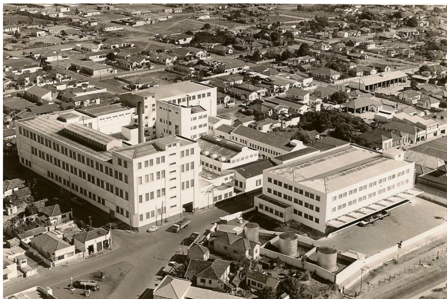
Figura 23: Fotografia panorâmica, sem data, de uma das principais indústrias de Marília, a Antártica, hoje, desativada, dando lugar a duas instituições de ensino, a ETEC e a FATEC, dividindo o antigo espaço fabril. Para as novas atividades não foram necessárias muitas mudanças na estrutura física da edificação. O fotógrafo, com certeza, registrou essa imagem aérea a pedido do proprietário. Autor: Desconhecido. Fonte: Comissão dos Registros Históricos.
