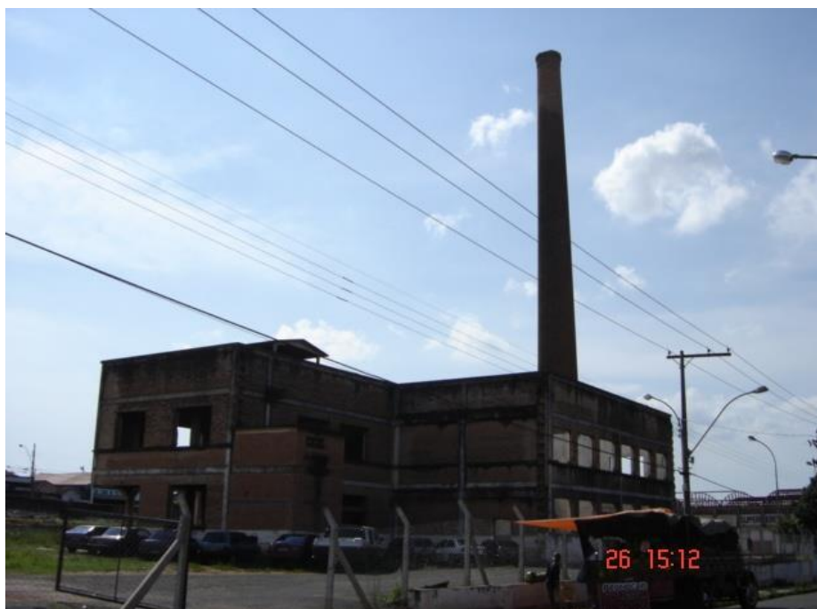
Figura 14: Indústria Matarazzo. Vista geral da casa das caldeiras e chaminé, antes da reforma, em 2005, mostrando o antigo uso do imóvel tombado, um estacionamento de veículos, sem nenhuma estrutura, em estado de ruínas e abandonado. Autor: Rodrigo Modesto Nascimento, 2005.
