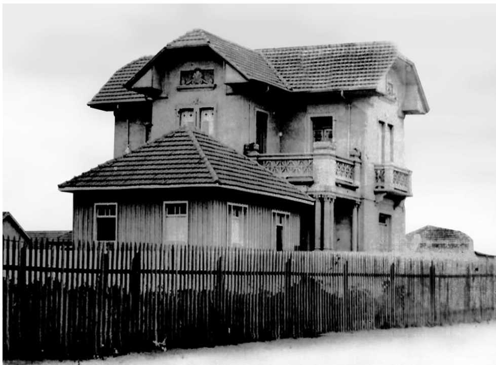
Figura 04: Sobrado da Rua Dom Pedro, 87, na década de 1930. O fotógrafo, provavelmente, procurou mostrar o aspecto imponente da edificação de alvenaria, singular para a época, porque a maioria das residências era construída de madeira, como o imóvel ao lado. Essa imagem também pertencente à coleção de fotografias da Comissão dos Registros Históricos, usada para apresentar a primeira residência de alvenaria de Marília, enfatizando, somente a arquitetura da mesma. Autor: Desconhecido. Fonte: Comissão dos Registros Históricos.
