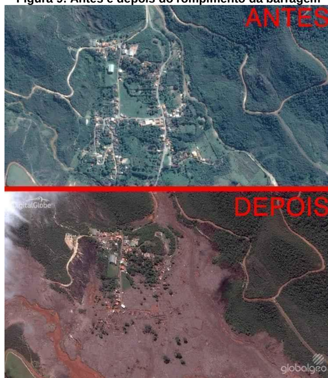
Figura 9: Antes e depois do rompimento da barragem
