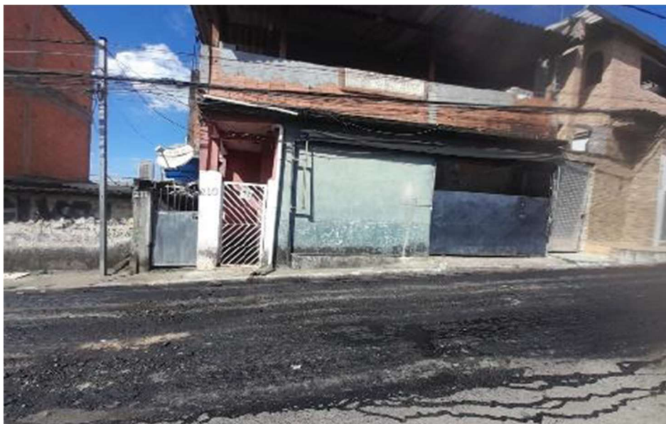
Figura 41 – Execução de fresagem asfáltica no trecho da vala 210
