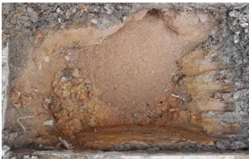
Figura 29 – Envoltória de areia executada na vala 208
