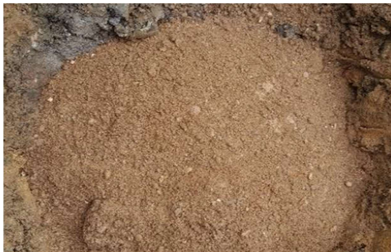
Figura 21 – Envoltória de areia executada na vala 9
