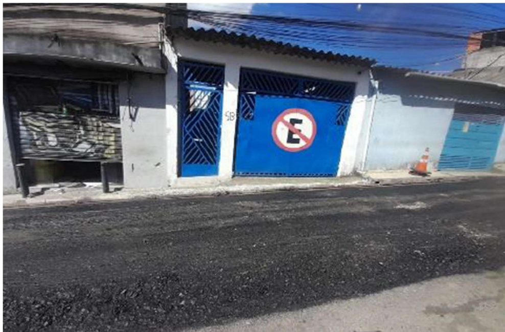
Figura 39 – Execução de fresagem asfáltica no trecho da vala 9B
