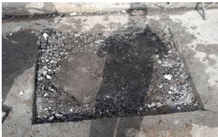
Figura 25 – Vala 9B com a reposição de RAP não espumado executada
