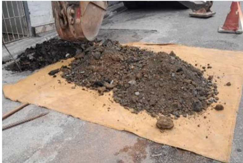
Figura 20 – Escavação da vala 9
