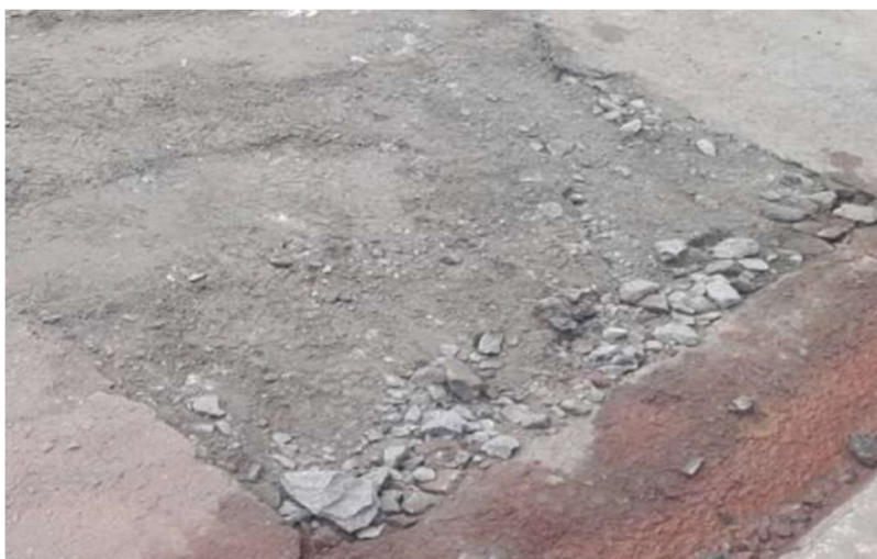
Figura 33 – Vala 210 com a reposição de BGS executada
