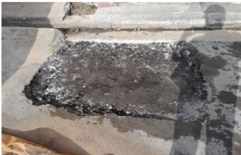
Figura 22 – Vala 9 com a reposição de RAP não espumado executada
