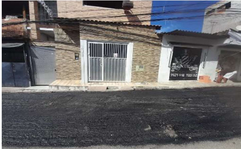
Figura 40 – Execução de fresagem asfáltica no trecho da vala 208
