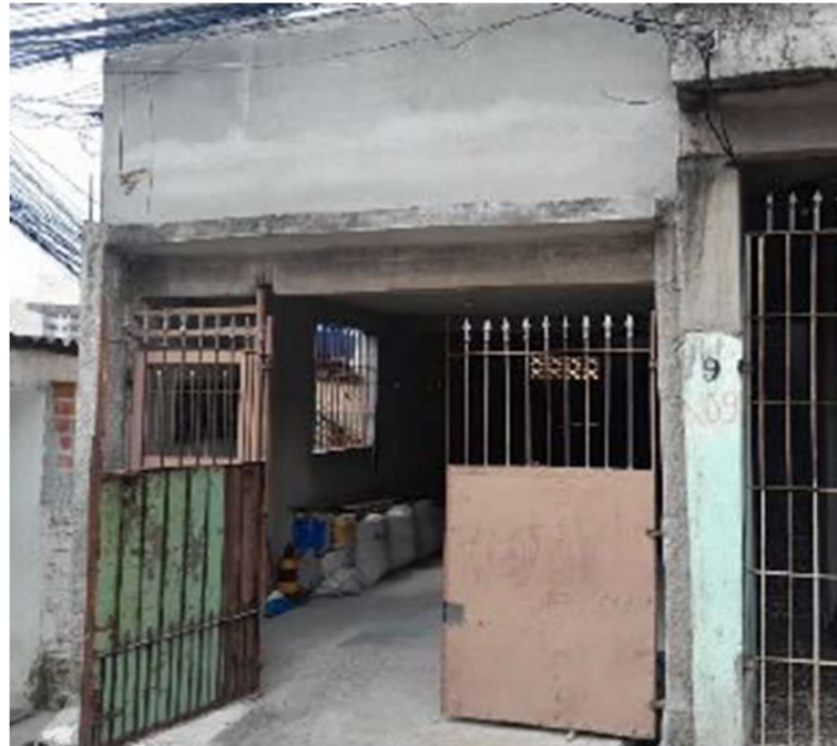
Figura 18 – Fachada do imóvel em frente a vala 9
