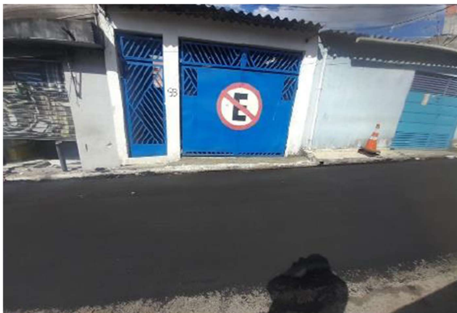
Figura 43 – Trecho da vala 9B com o recapeamento asfáltico concluído
