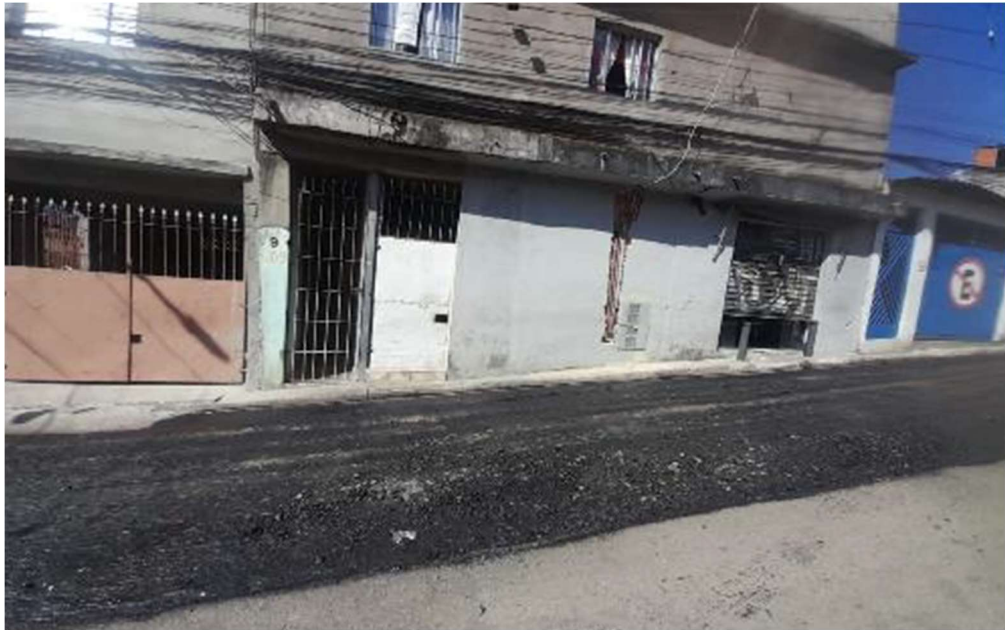
Figura 38 – Execução de fresagem asfáltica no trecho da vala 9
