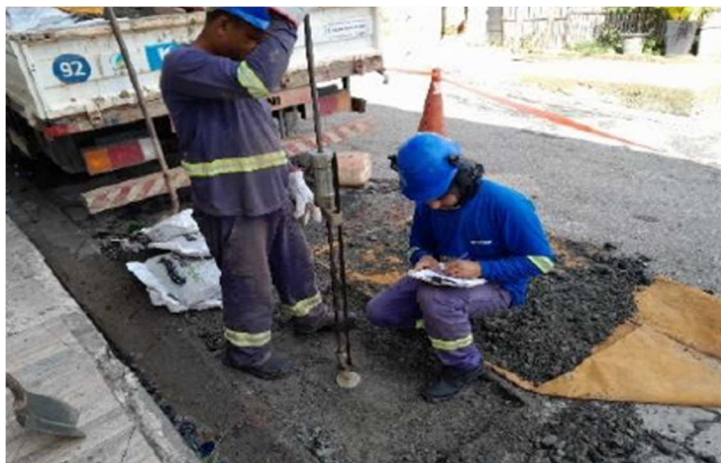
Figura 30 – Vala 208 após a reposição de BGS executada
