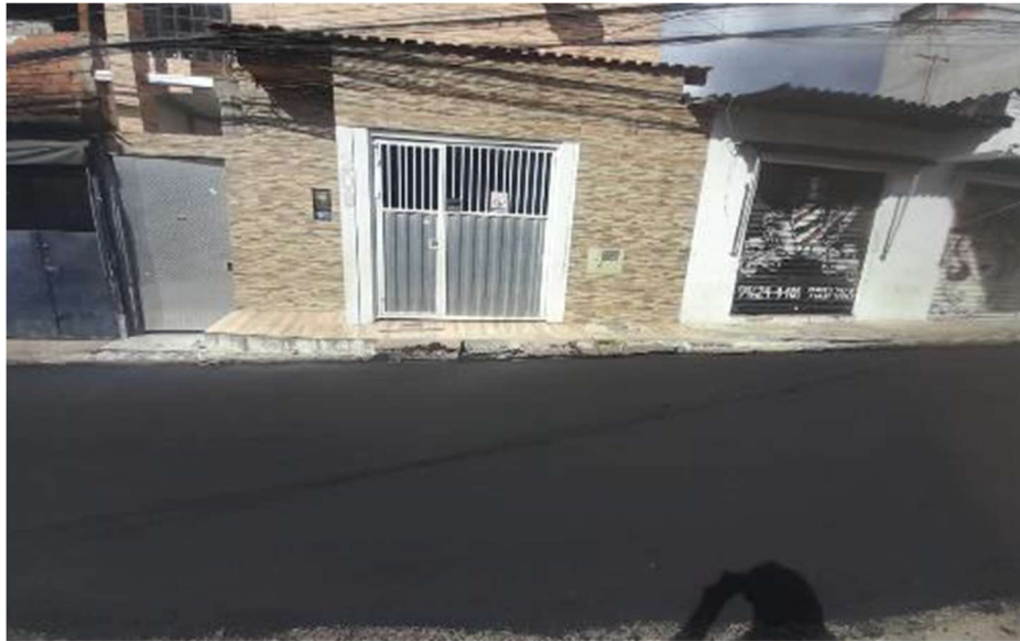
Figura 44 – Trecho da vala 208 com o recapeamento asfáltico concluído
