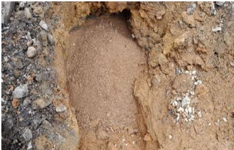
Figura 32 – Envoltória de areia executada na vala 210
