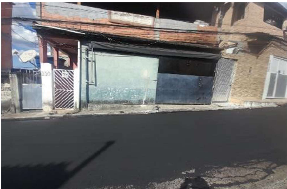
Figura 45 – Trecho da vala 210 com o recapeamento asfáltico concluído
