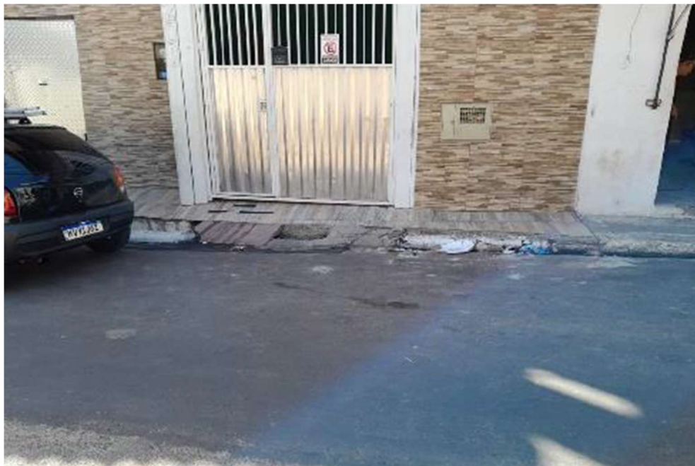
Figura 48 – Trecho da vala 208 após 30 dias
