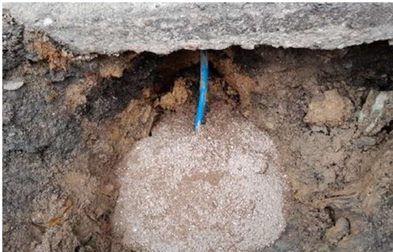
Figura 24 – Envoltória de areia executada na vala 9B
