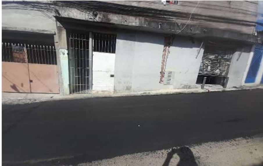
Figura 42 – Trecho da vala 9 com o recapeamento asfáltico concluído
